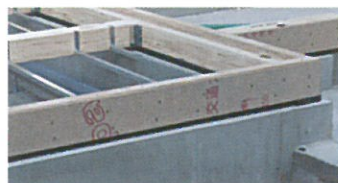
戸建・大引ネダ下部
